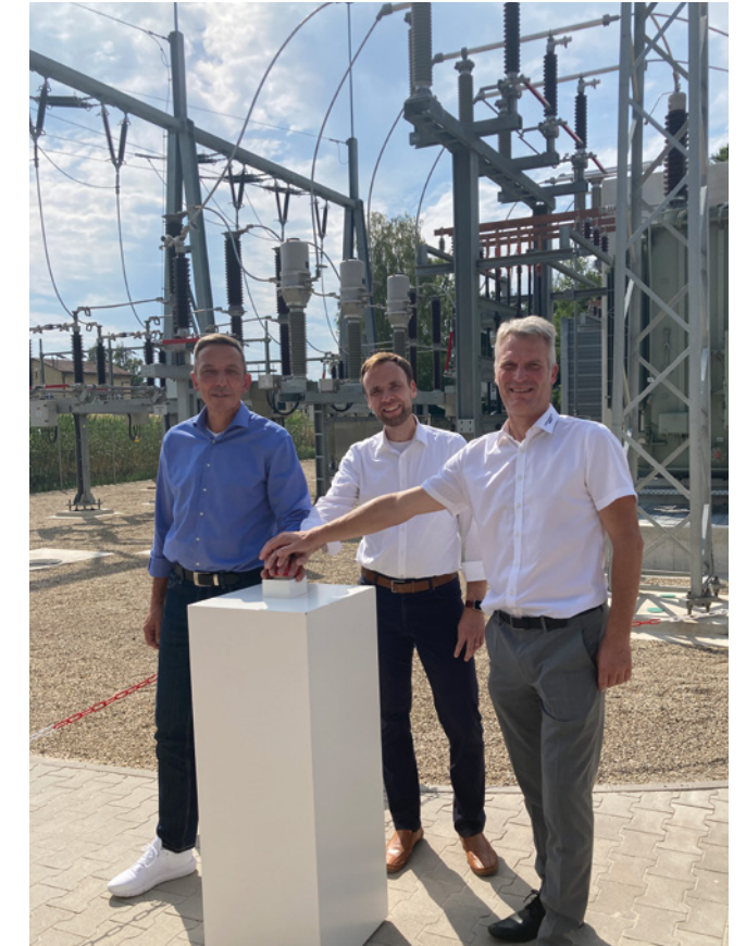
Nach knapp zwei Jahren Bauzeit war es im Juli so weit: Rastatts Bürgermeister Raphael Knoth, Olaf Kasprzyk, Geschäftsführer der Stadtwerke Rastatt, und Stefan Ringwald (l.), Geschäftsführer des Generalunternehmers Netze BW, nahmen das neue Umspannwerk Niederbühl feierlich in Betrieb.
